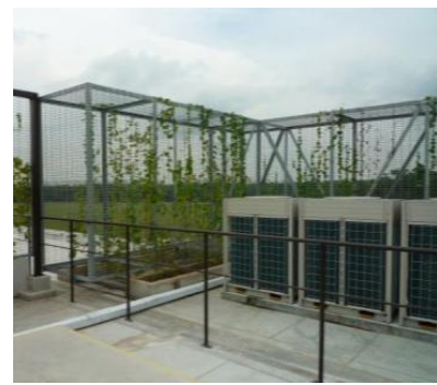
屋面攀爬类三维网格支撑系统
