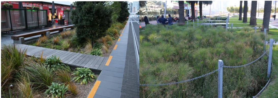
图 8-6 生物滞留设施实景图
